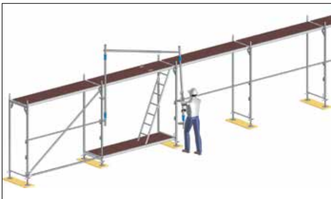
Фиг. 25: Монтаж на (AGS) паранет в секцията за достъп
