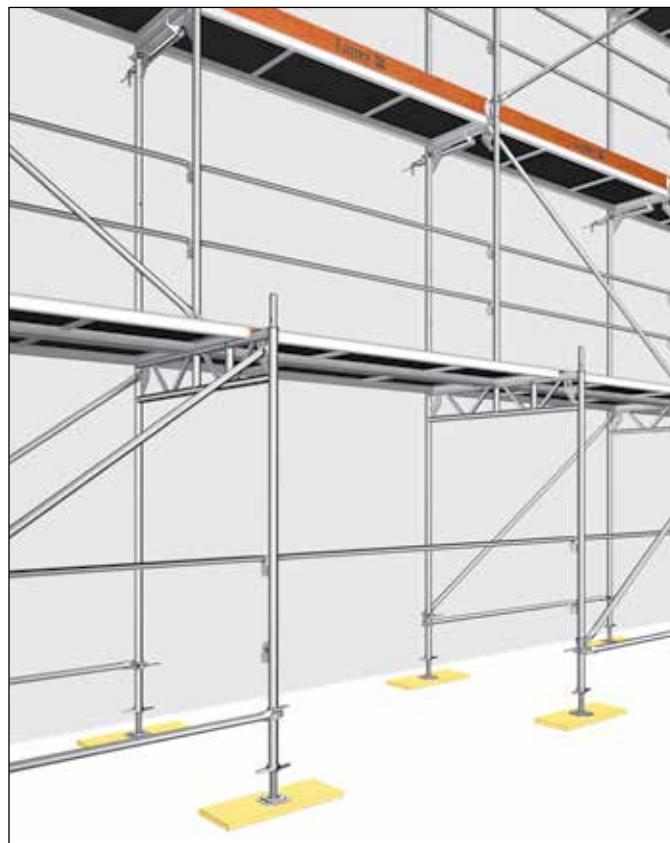
Фиг. 105: Монтаж на тунелни рамки
