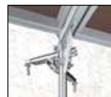
2 връзки за анкер , свързани във V-форма с по една стандартна връзка, към вътрешния вертикал.
